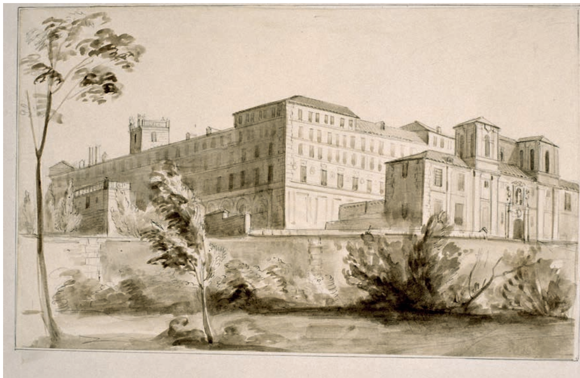
Vista del Convento de los Afligidos y el Cuartel de las Reales Guardias de Corps, h. 1830. Fundación Lázaro Galdiano
