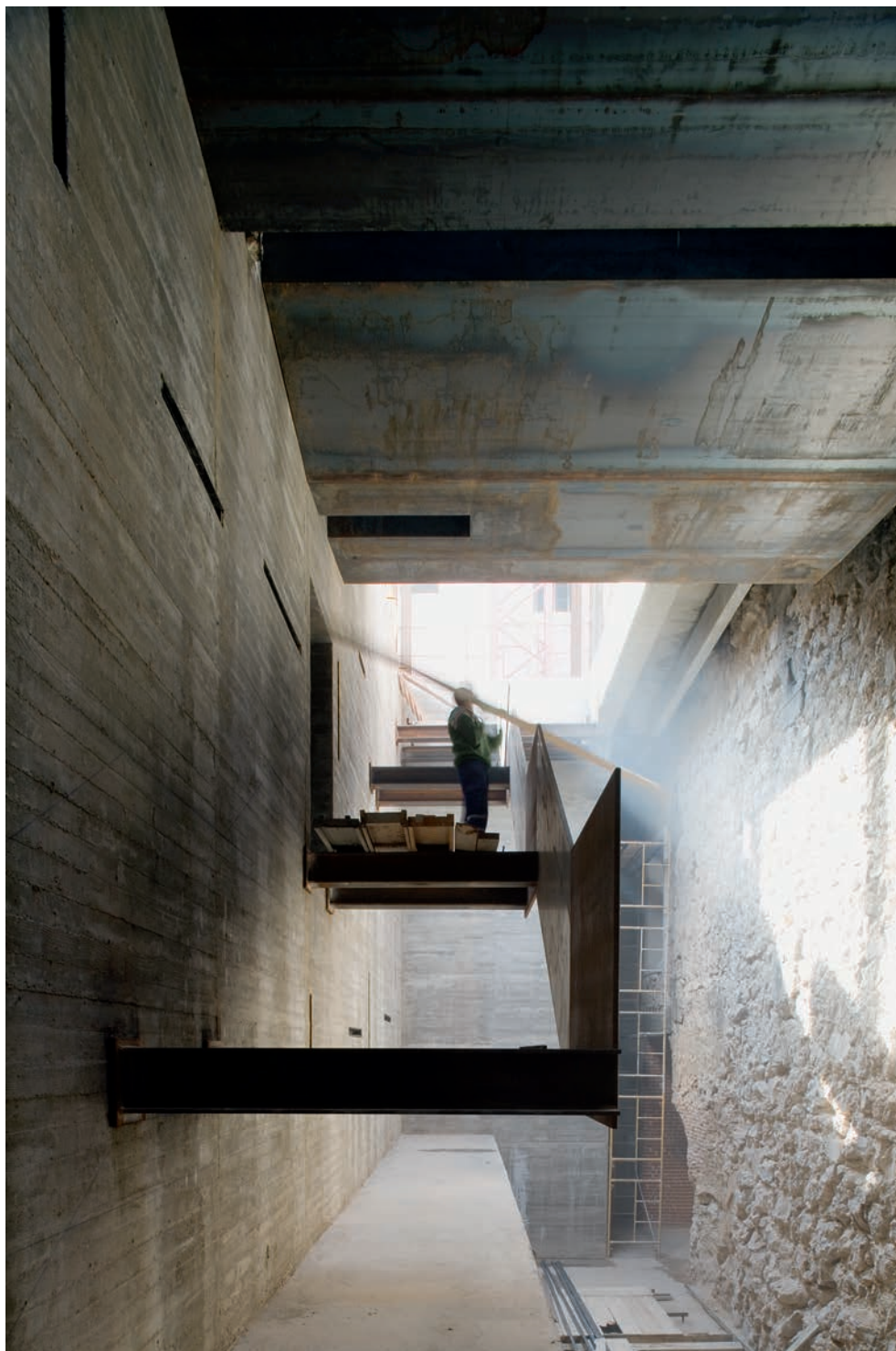
Ejecución de la estructura de la nueva escalera de acceso e iluminación del sótano desde el patio sur
