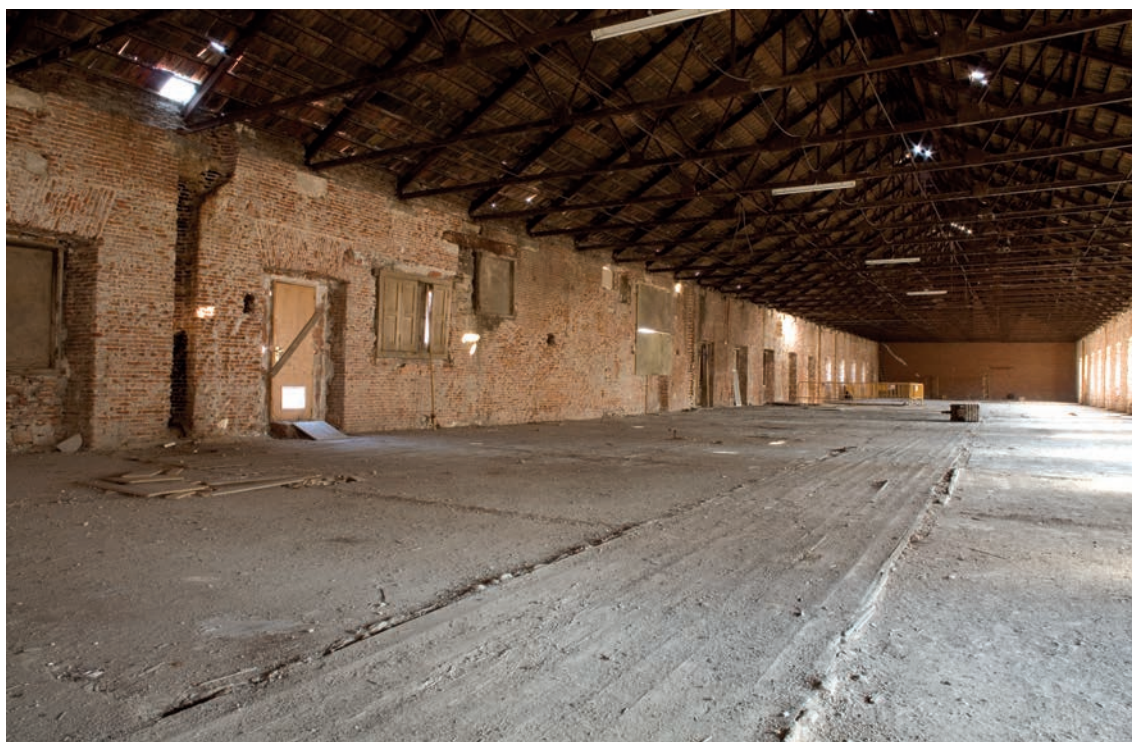
Estructura de la primera planta del ala sur del patio central durante el desmontaje del falso techo
