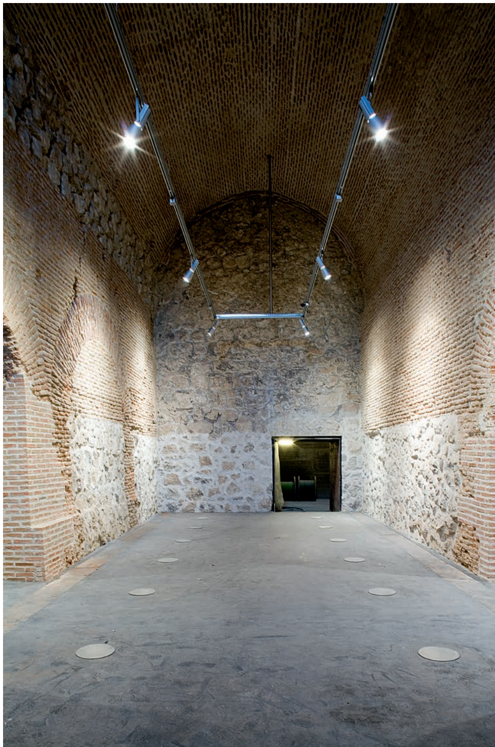
Ejecución de nuevas instalaciones en la zona de bóvedas del sótano con un mínimo tratamiento
