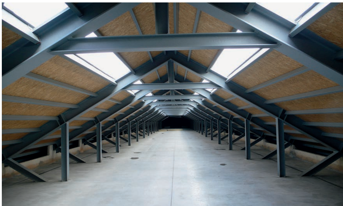
Espacios bajo cubierta para la adecuación de instalaciones
