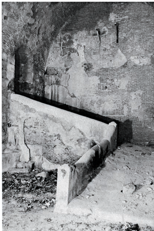
Bóvedas subterráneas. Ordenación de los Cuarteles del Conde Duque y su entorno, José Luis Ibarrondo García, 1967. SH. Fundación Arquitectura COAM
