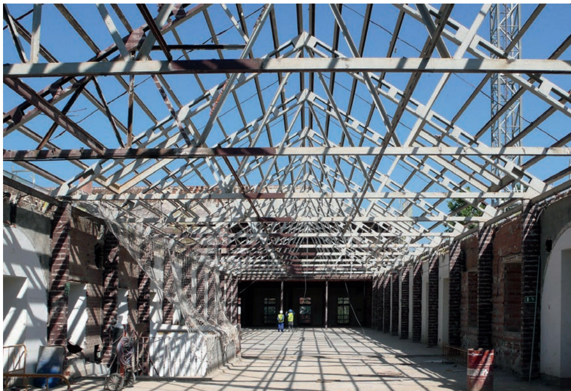
Aspecto de las labores de revisión y adecuación de las estructuras existentes
