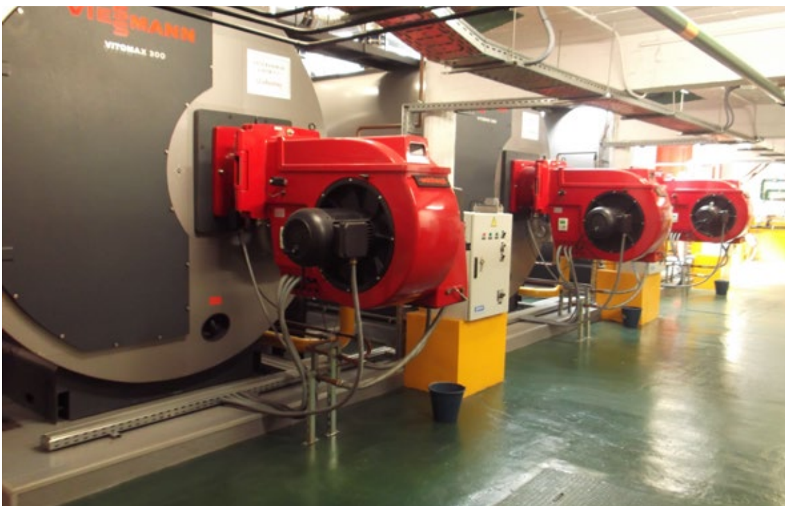
Imagen 22: Central Térmica de Meseta de Orcasitas. (Usura) Fuente: Elaboración propia
