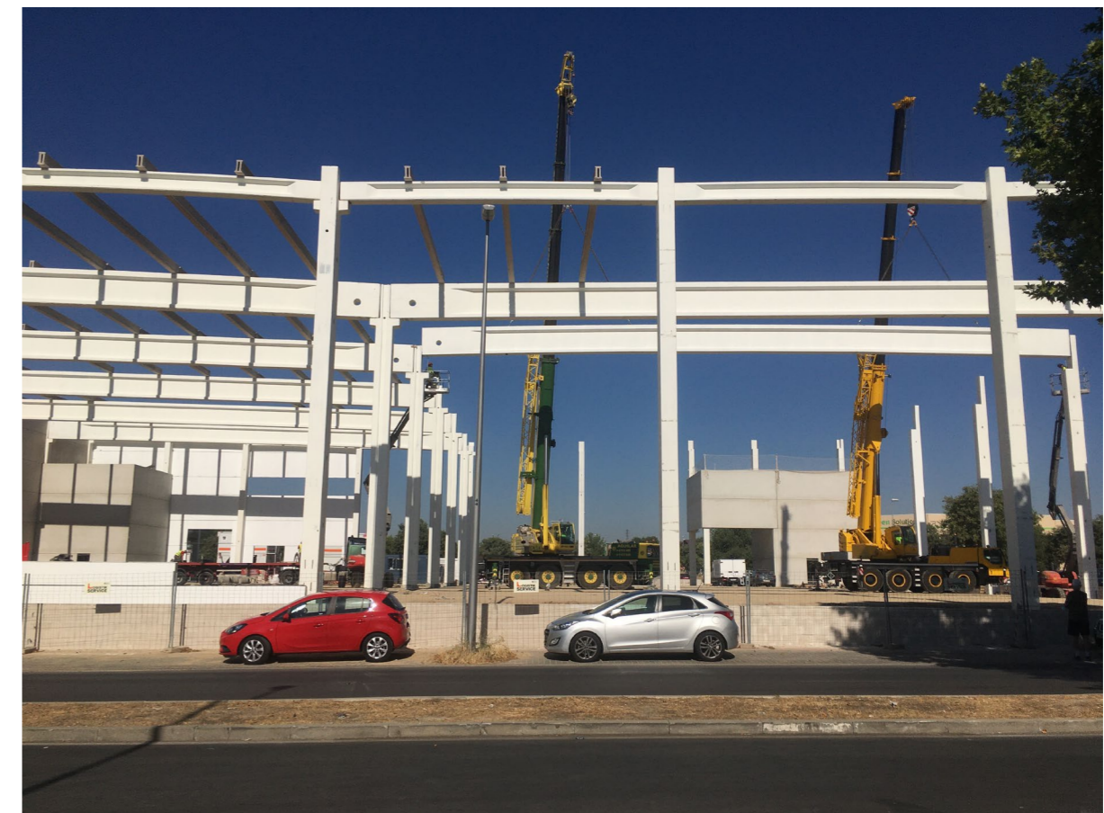
Figura 3.5 Construcción de la Plataforma Logística Last Mile Logistics en el Área Industrial de Villaverde en julio 2022
