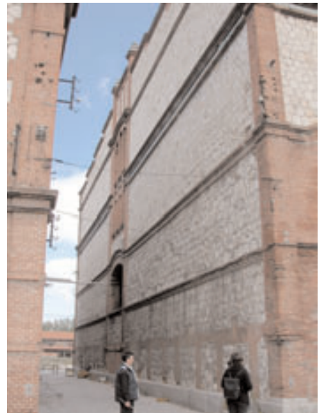
Vista del alzado lateral de las mondonguerías
