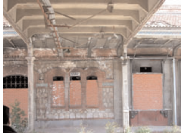
Detalle del alzado occidental y encuentro con pasarela
