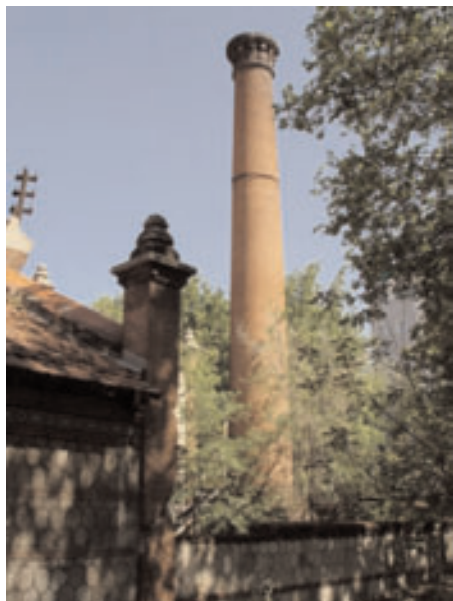
Vista de la chimenea
