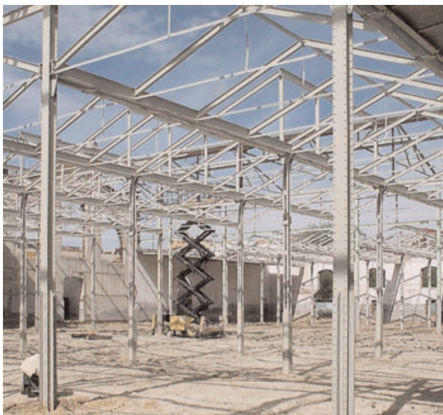
Proceso de restauración de la estructuras
