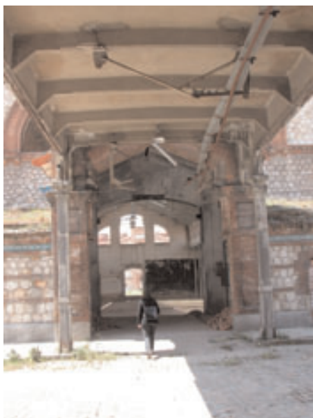
Acceso de la marquesina
