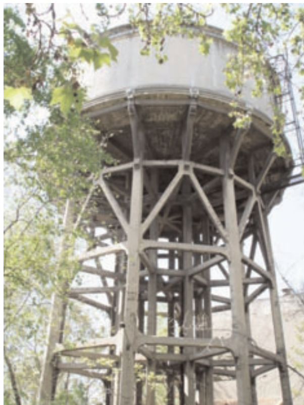
Vista exterior estructura y cuba
