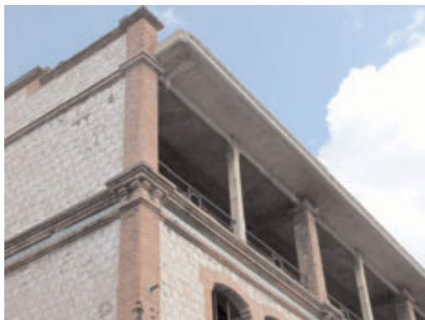
Detalle exterior del secadero de sebos
