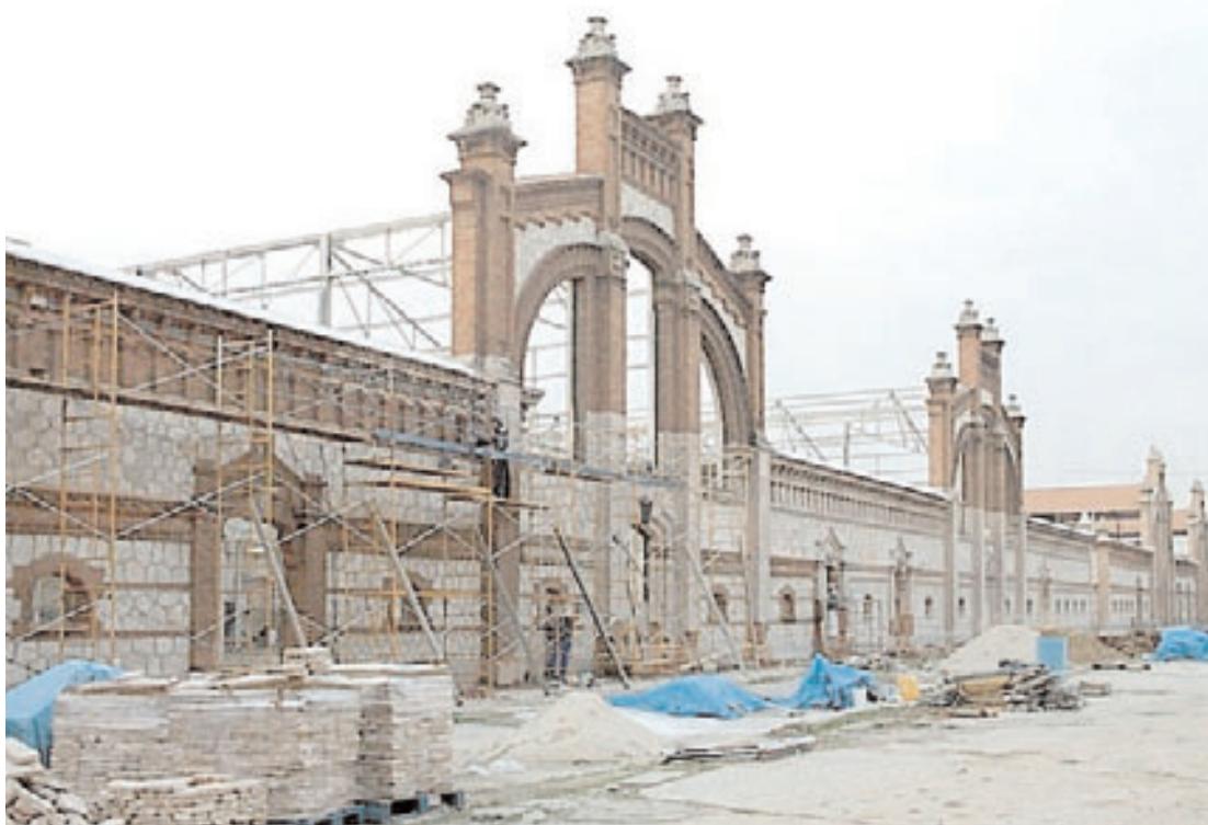
Fachada en restauración
