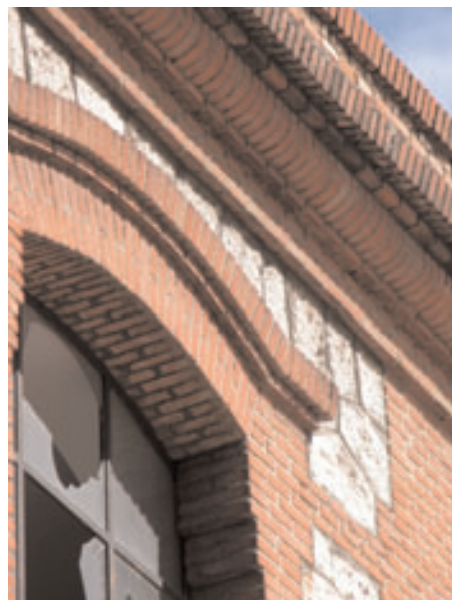
Detalle de hueco
