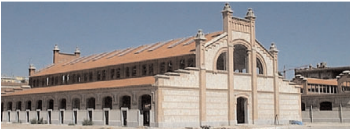
Vista exterior tras la restauración (alzados norte y oeste)
