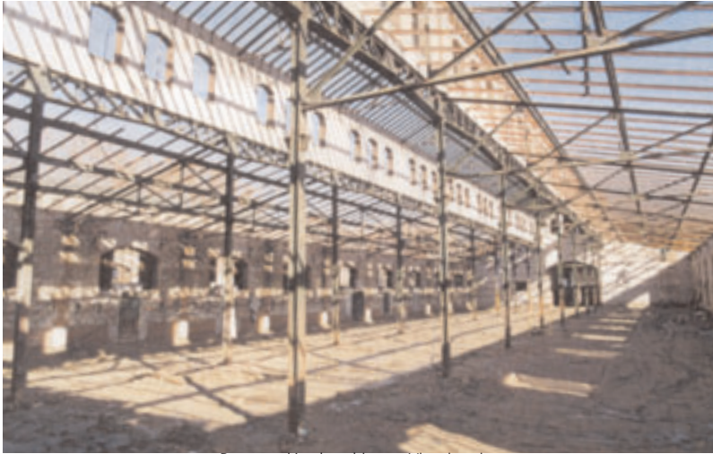
Restauración de cubiertas. Vista interior.
