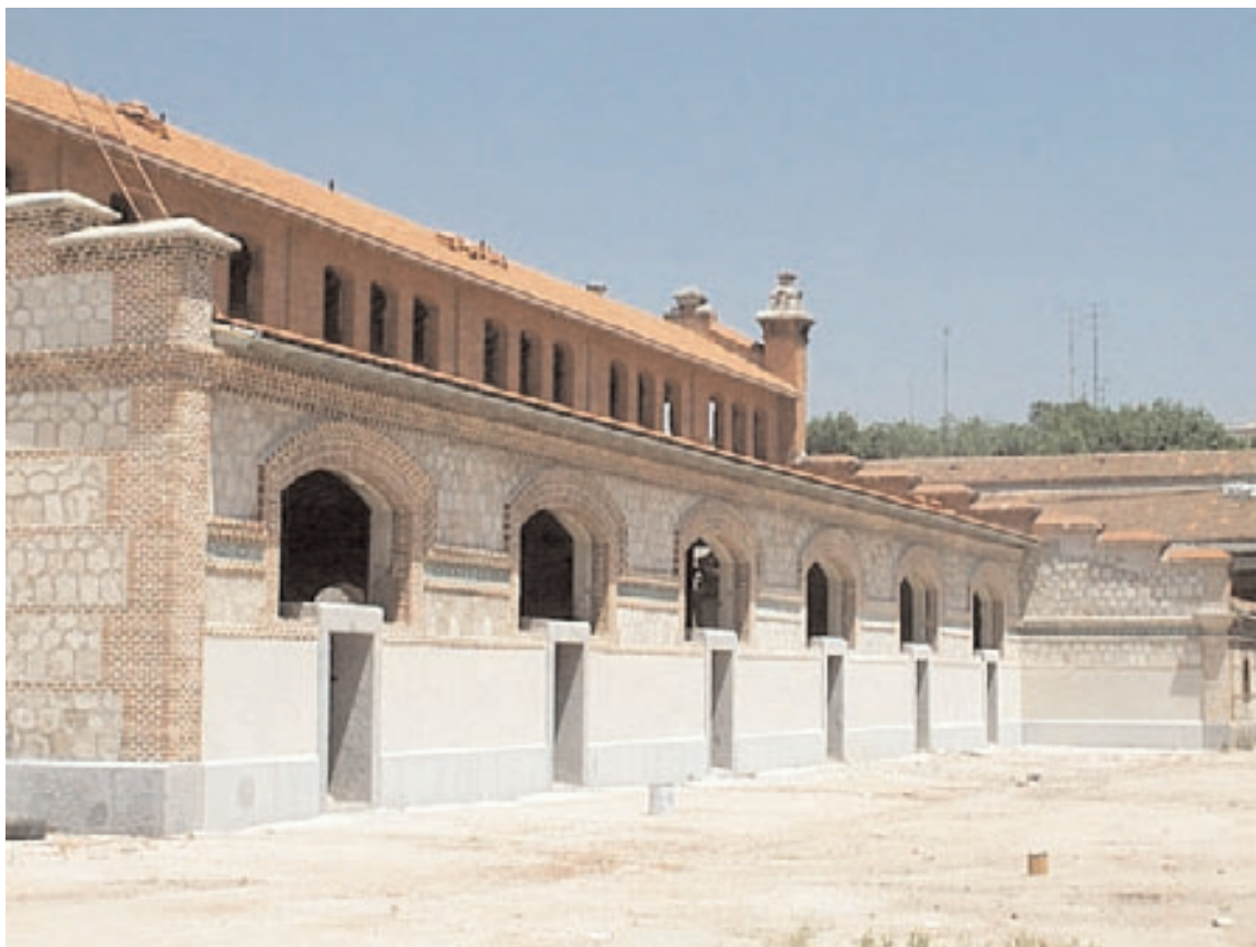
Vista exterior alzado sur
