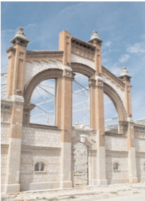
Fachada en restauración
