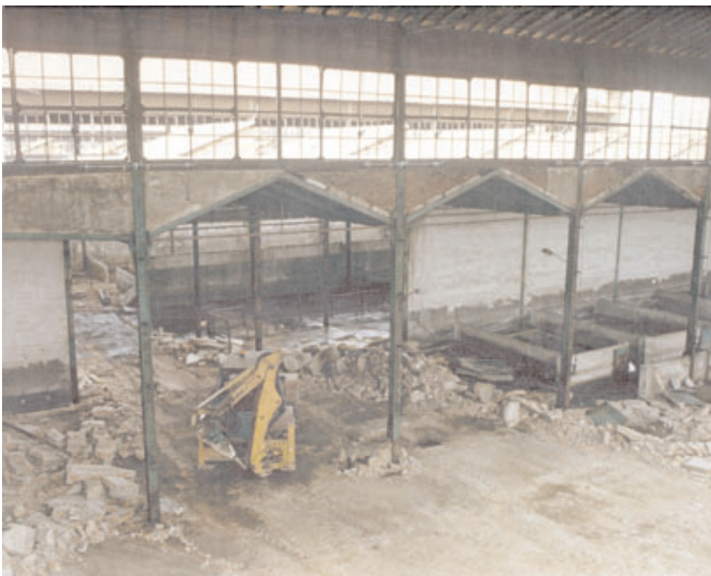
Estado del interior de las naves
