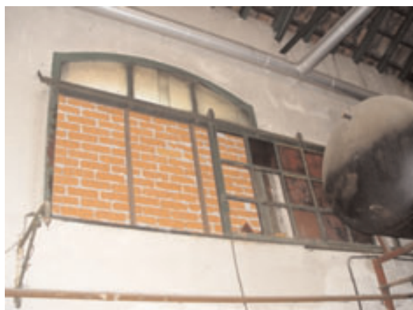
Detalle de hueco
