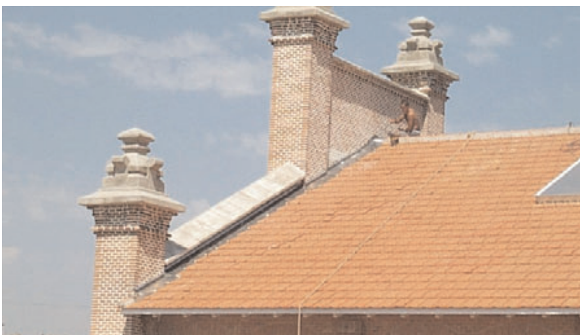
Restauración de cubierta
