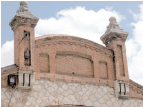
Detalle de remate de fachada del garaje
