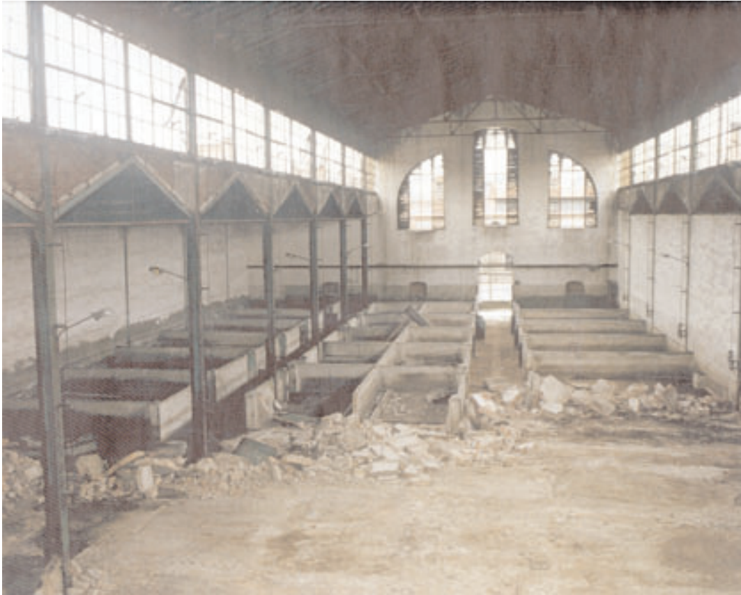
Estado del interior de las naves
