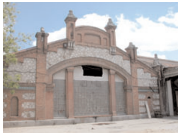
Vista exterior del alzado occidental del garaje
