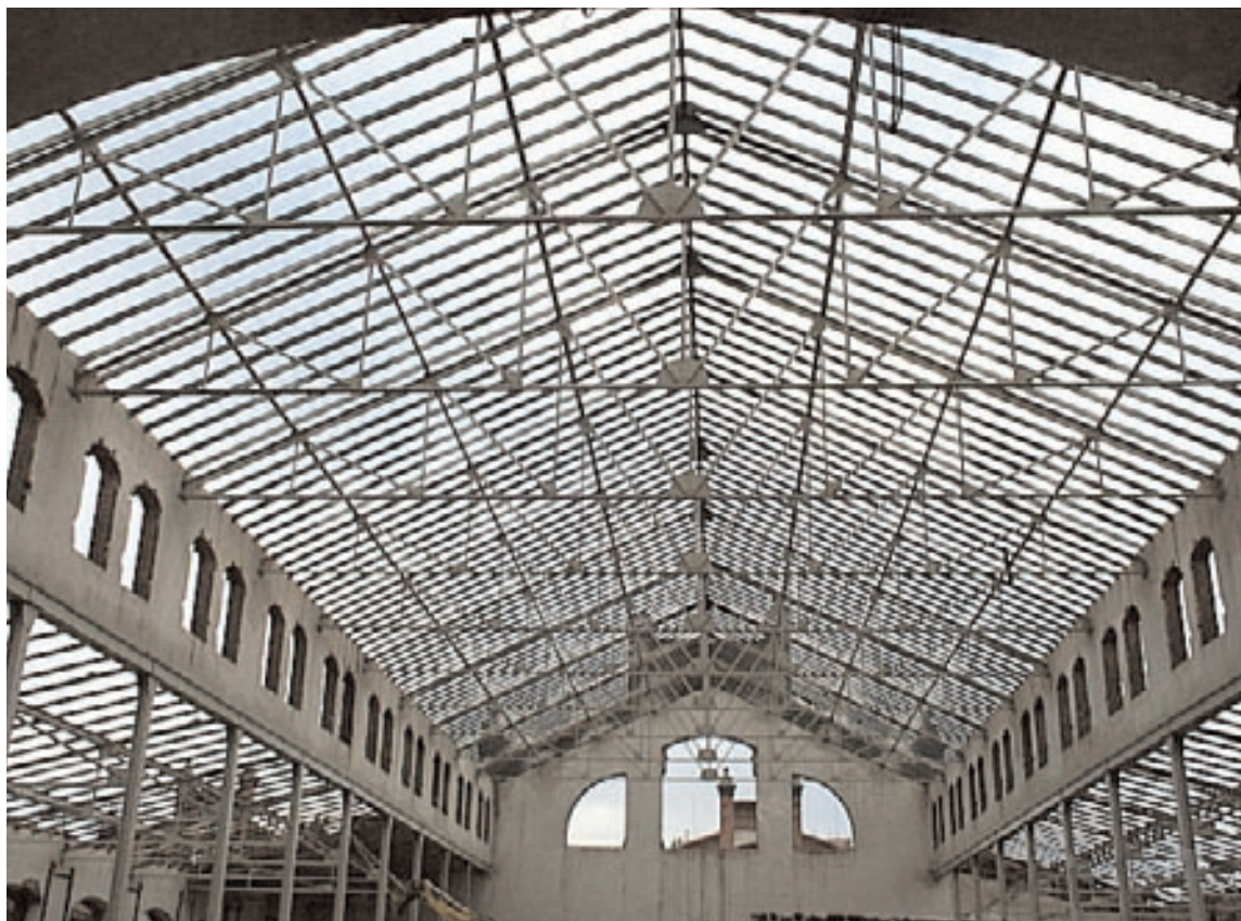
Vista interior de la cubierta
