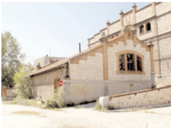
Vista de los alzados norte y este del taller de vaciado
