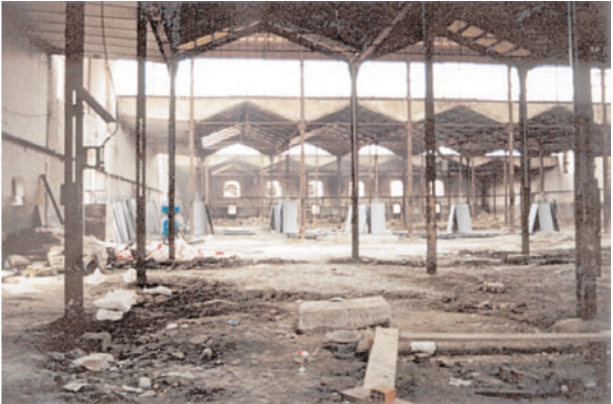
Estado del interior de las naves
