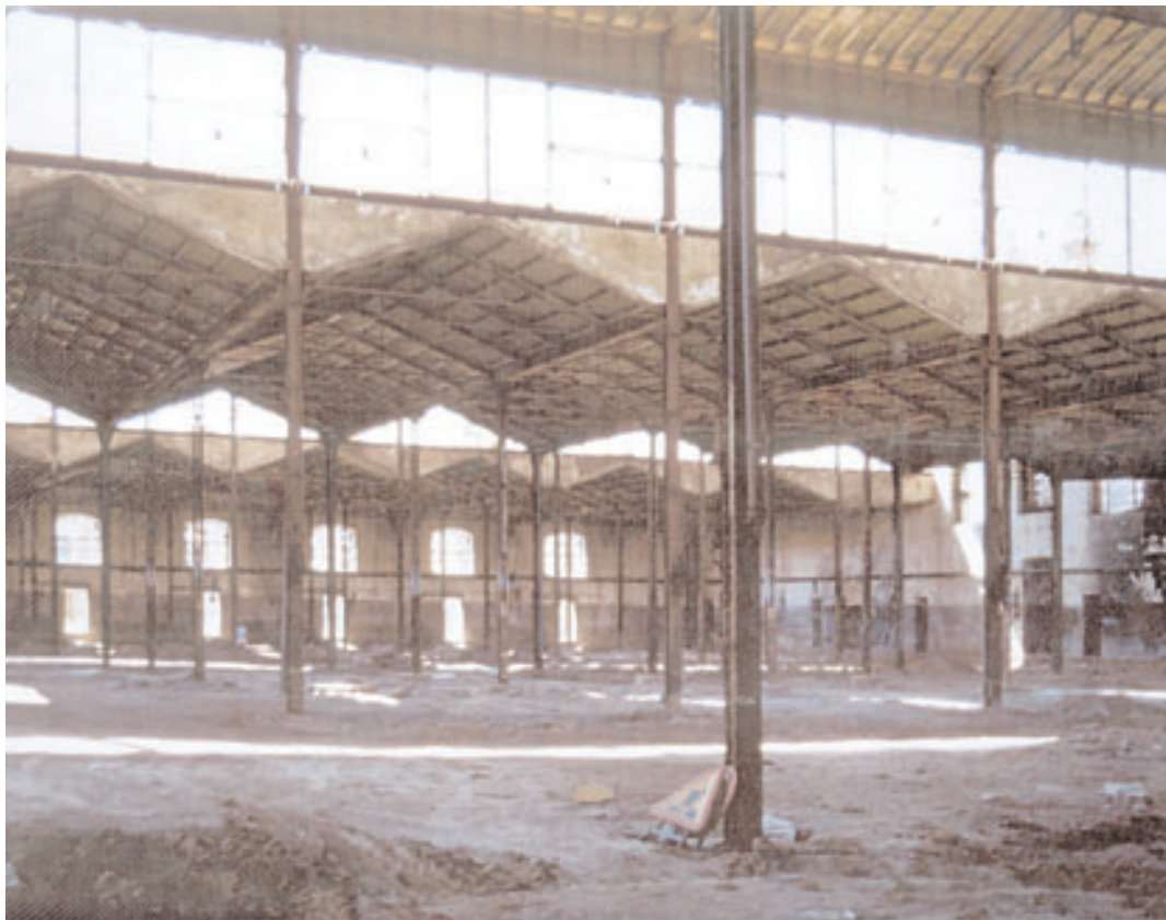
Estado del interior de las naves
