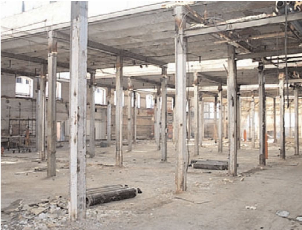
Vista interior zona de desviente
