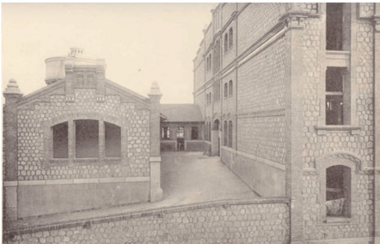
Taller de vaciado y rampa de acceso a las mondonguerías
