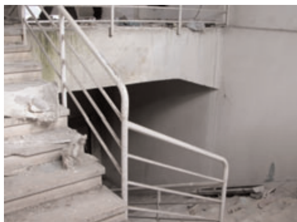
Vista de la escalera
