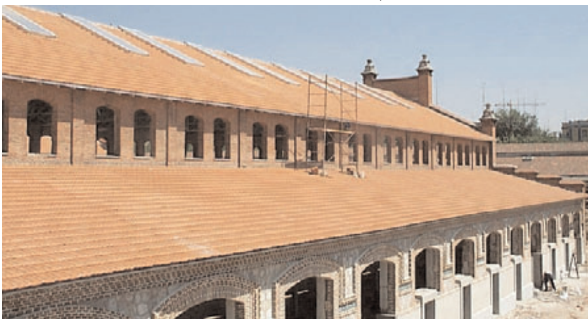
Vista exterior alzado sur
