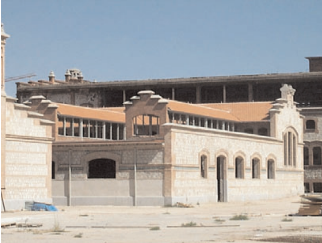
Vista exterior tras la restauración (alzados norte y oeste)
