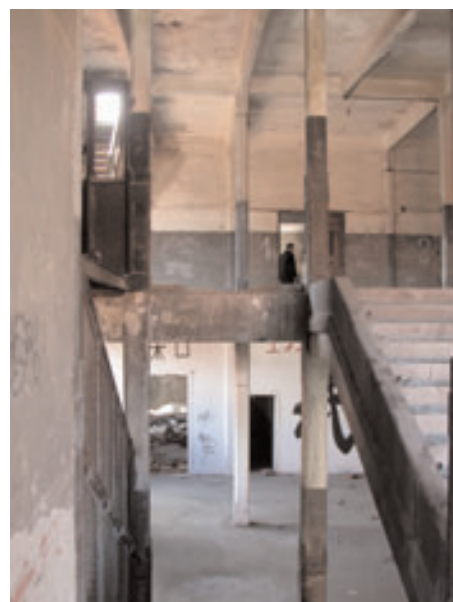
Vista del hueco de escalera
