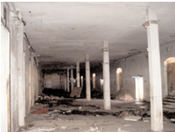
Vista interior de los colgaderos
