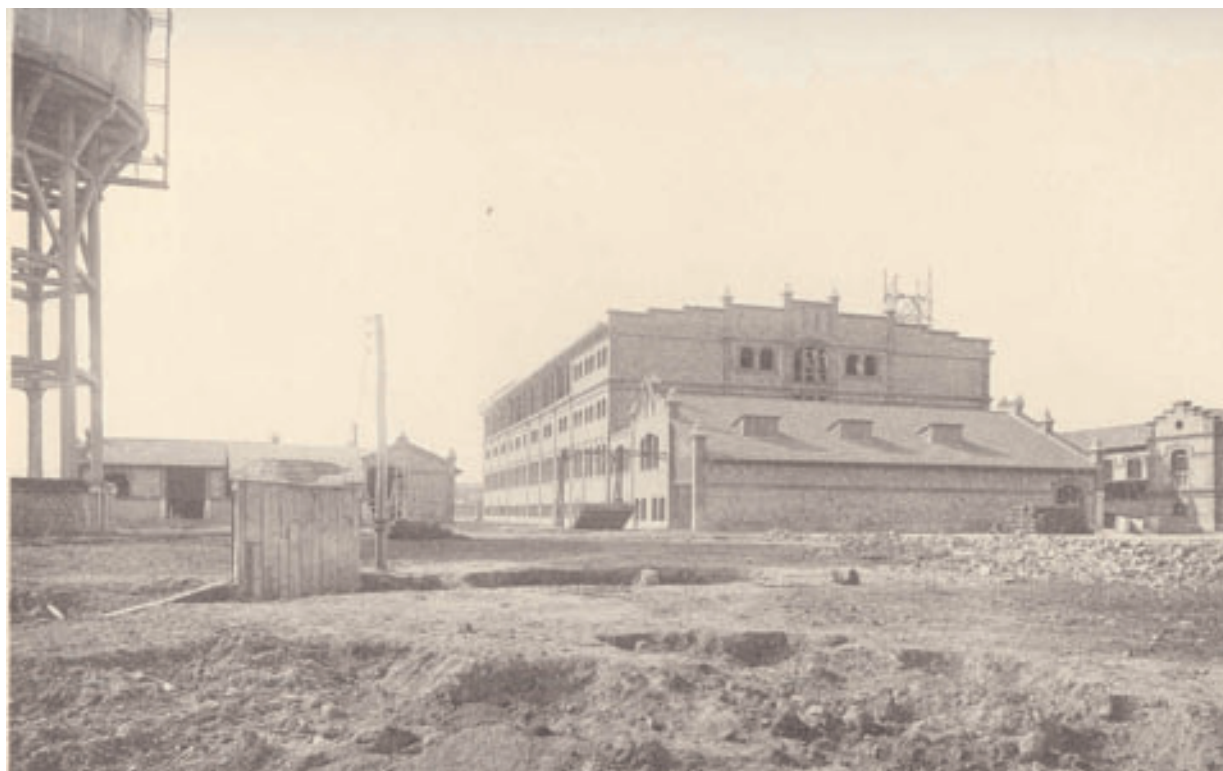
Vista general desde el este
