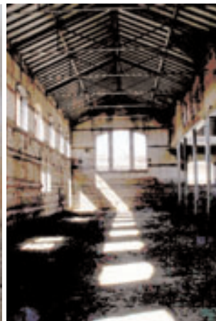
Vista interior nave de matanza
