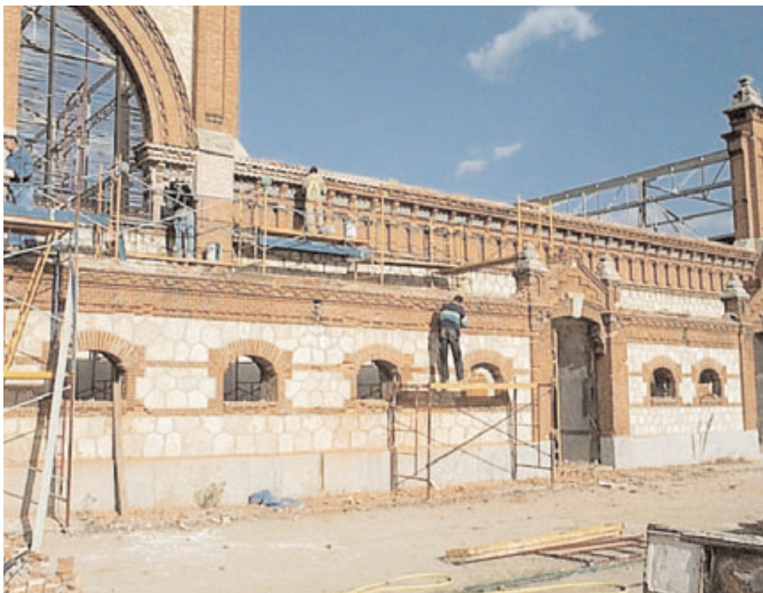
Fachada en restauración
