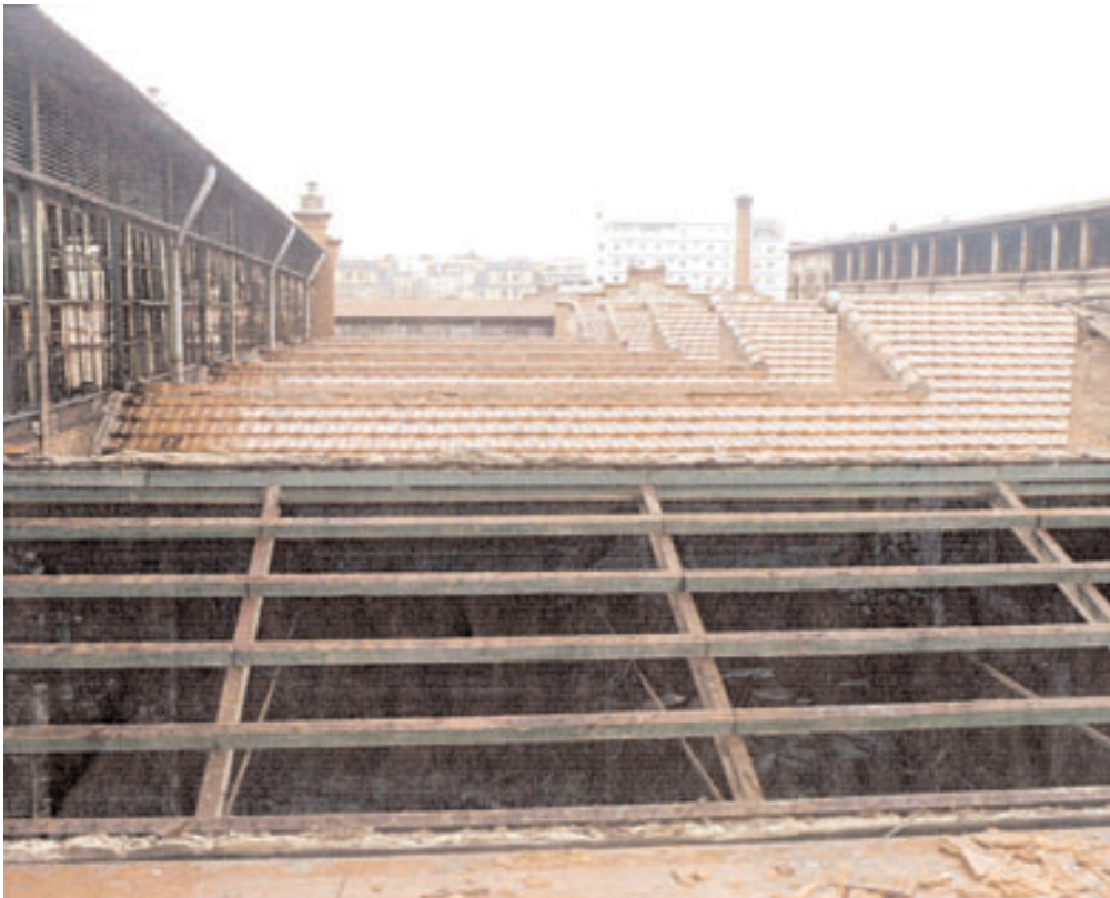
Estado de la cubierta y proceso de restauración
