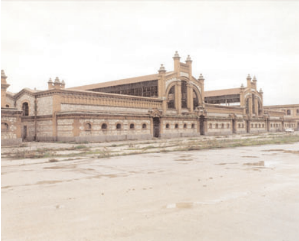
Estado de las fachadas
