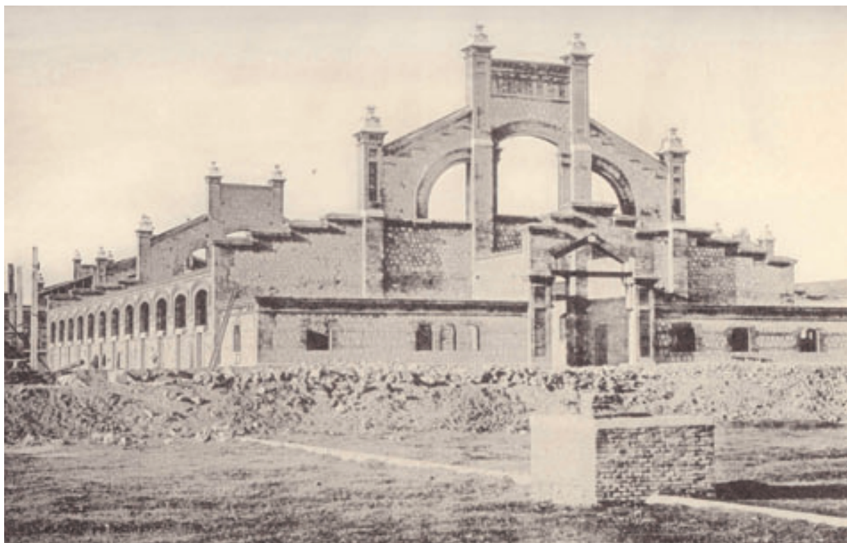
Nave de degüello de ganado lanar en construcción, enero de 1916. Publ.: Luis Bellido, El nuevo Matadero y Mercado de Ganados , 1918.
