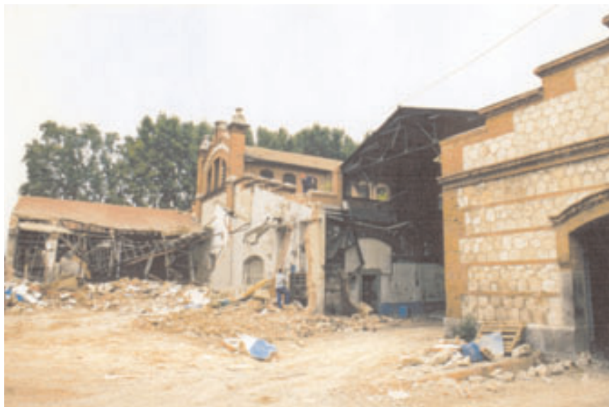
Proceso de demolición
