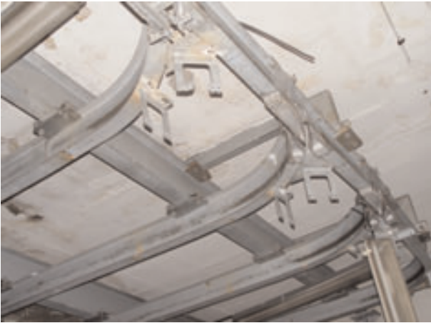
Detalle del sistema aéreo de transporte de canales
