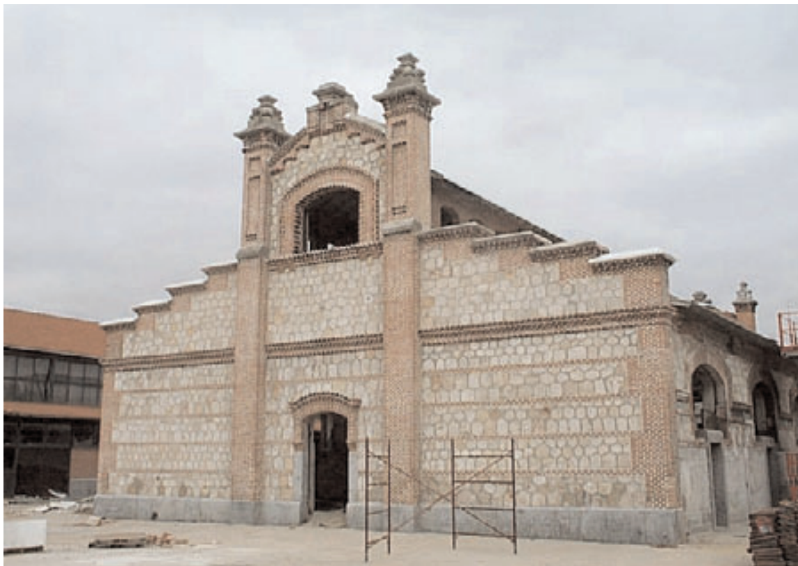
Vista exterior tras la restauración (alzado oeste)
