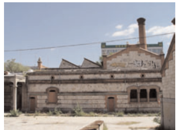
Sala de máquinas Vista exterior del alzado occidental
