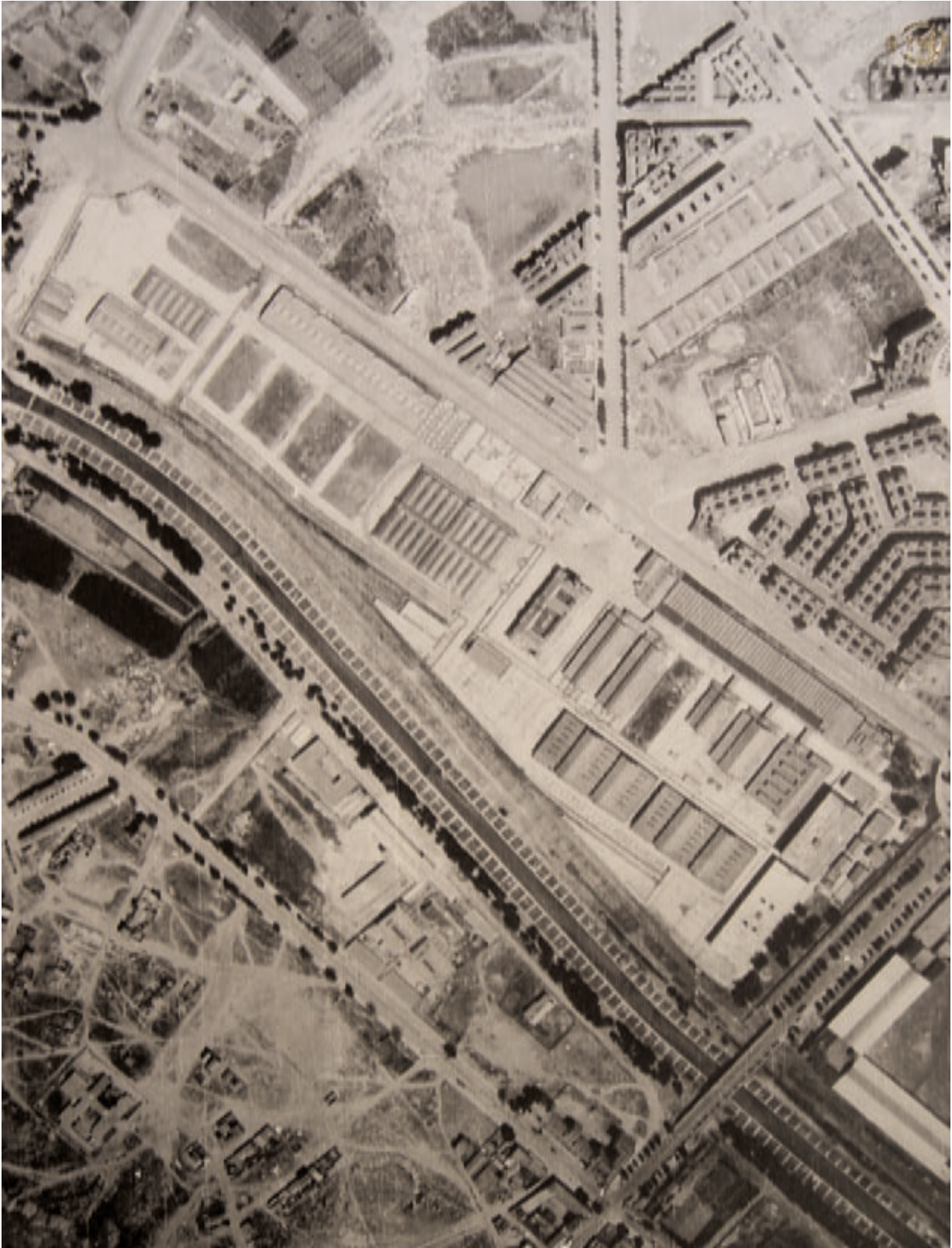
Vista aérea vertical del Matadero de Madrid en 1946. CECAF.
