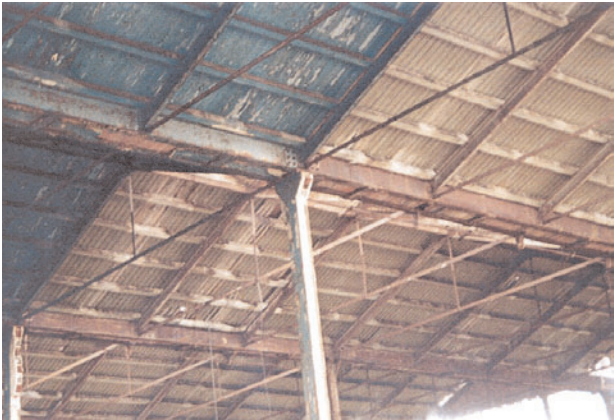
Estado de pilares y cimentación
