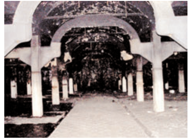
Vista interior de las cámaras frigoríficas
