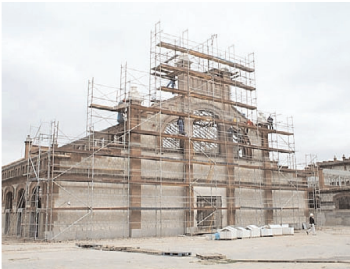
Restauración alzado oeste
