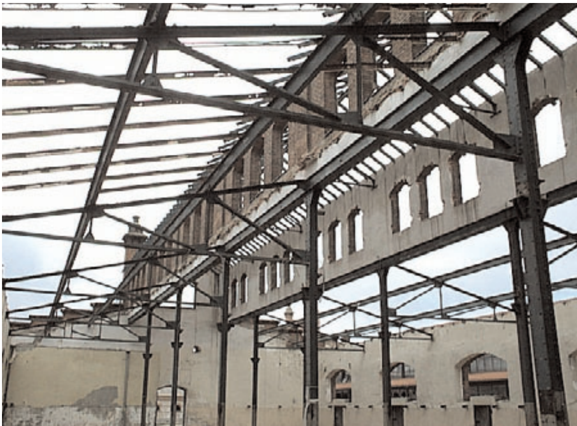
Vista interior de la cubierta
