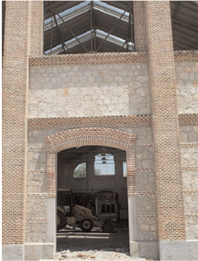
Detalle restauración de huecos
