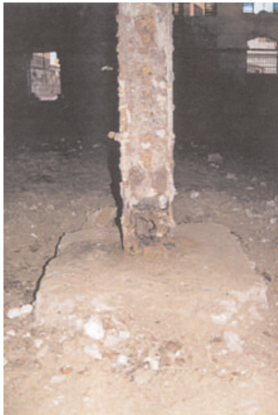
Estado de pilares y cimentación
