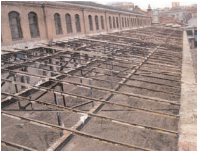
Restauración de cubiertas. Vista exterior.
