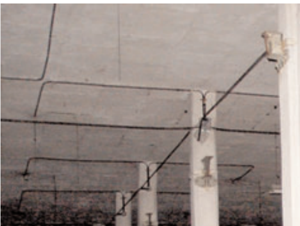
Vista interior de la nave de oreo de cerda
