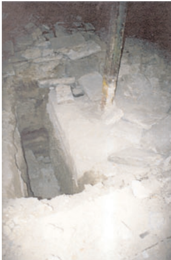
Estado de pilares y cimentación
