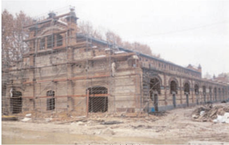
Restauración de fachadas
