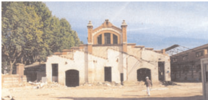
Proceso de demolición
