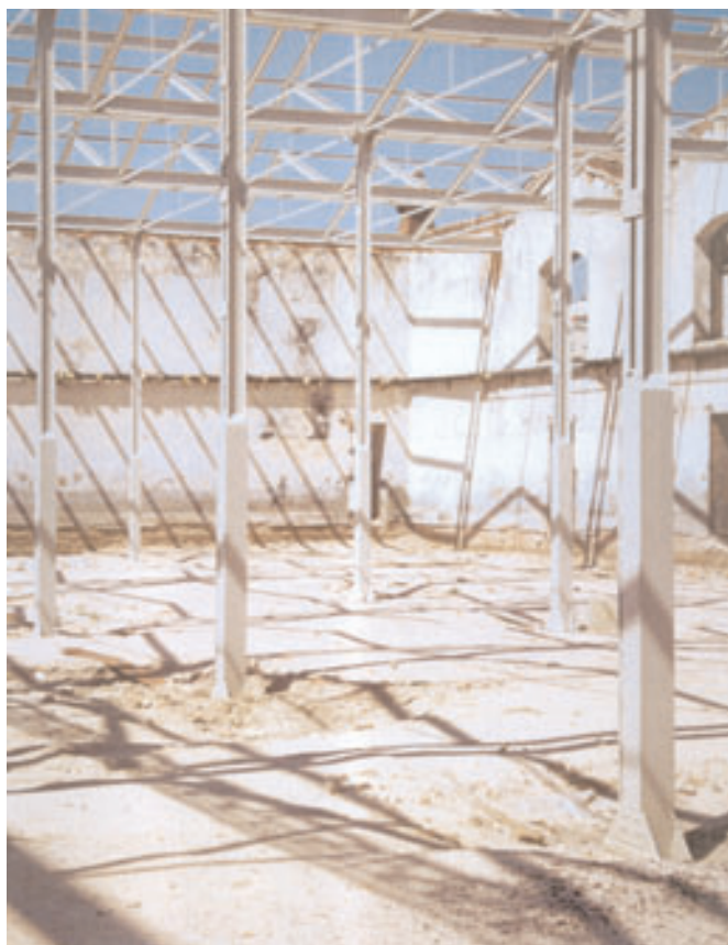
Proceso de restauración de la estructuras
