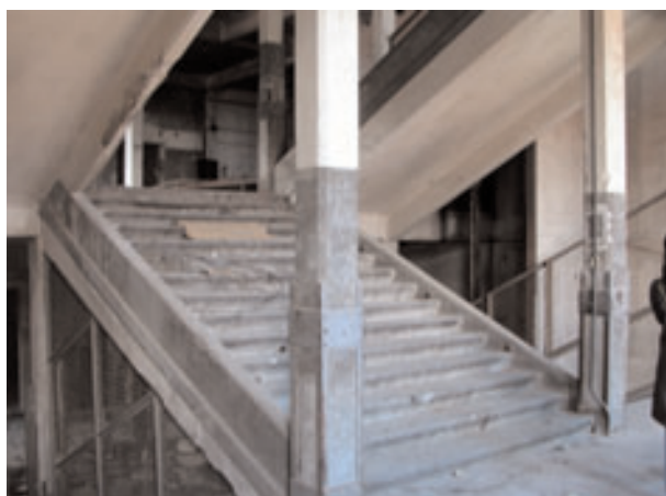
Vista de la escalera
