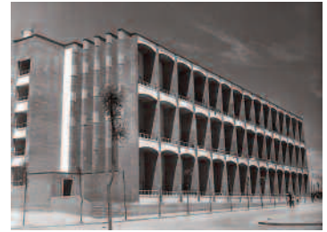
Edificio de viviendas Virgen del Pilar
