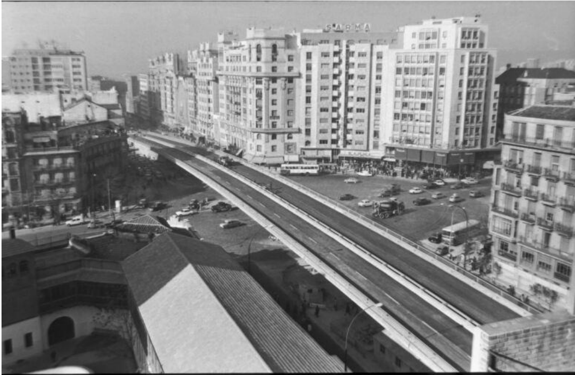
El paso elevado de Cuatro Caminos antes de inaugurarse. Fotografía de Martín Santos Yubero. Fuente: Archivo Regional de la Comunidad de Madrid
