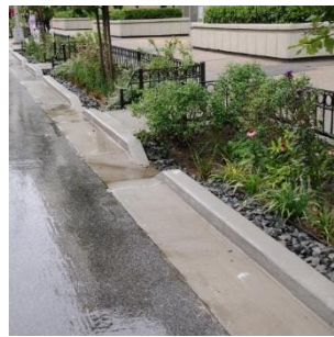
Figura 114. Ejemplo de "jardín de lluvia" o "rain garden" posicionado entre la carretera y la acera. Fuente: www.nyc.gov
